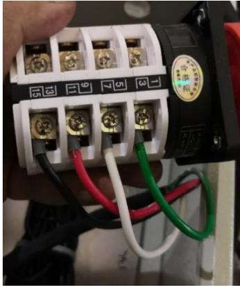
*Ilustración 25: Conexión de alimentación del variador*
